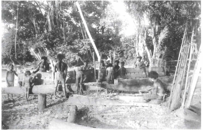
Abb. 20: Anpassen der Planken beim Bau eines Handelsbootes.
