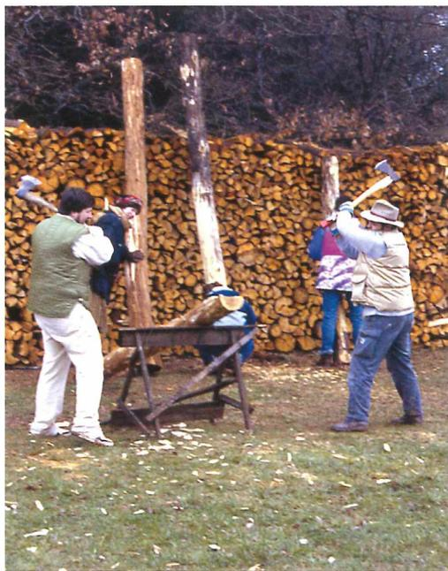
Abb. 3: Zurichten der Verbindungen mit dem Beil.
