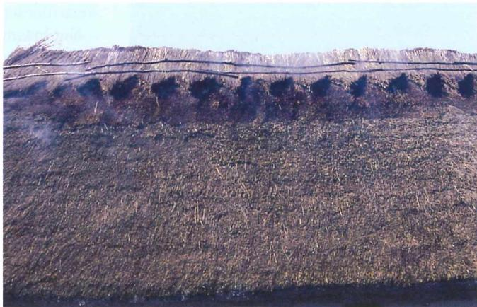
Abb. 18: Firstabschluss der Deckung. Foto: J. P. Zeitler.
