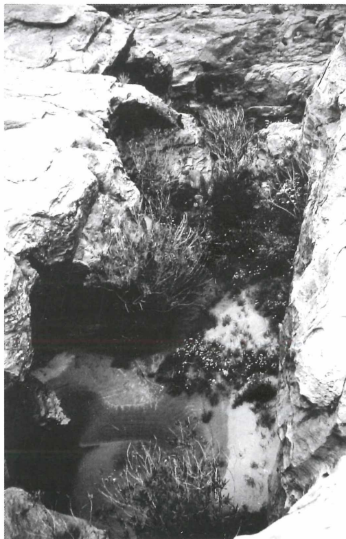
9B Rückhaltebecken im oberen Abschnitt der Sturzwasserführung (1980).
