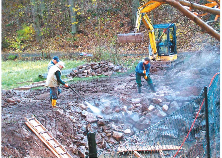
Arbeiten zum Hochwasserschutz am Bachbett
