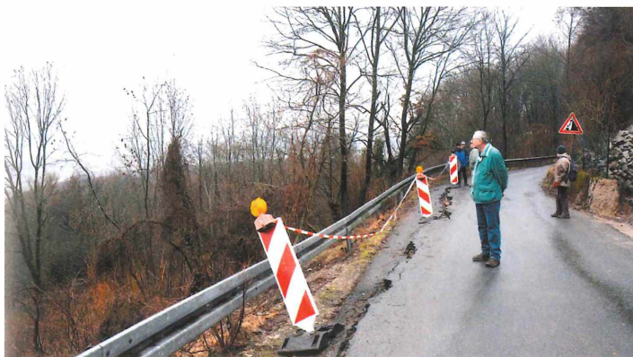
Abb. 4: Aktive Rutschung im Opalinuston bei Reifenberg, unmittelbar an der Basis der durch den Doggersandstein führenden Auffahrt zur Vexierkapelle (7. März 2009)
