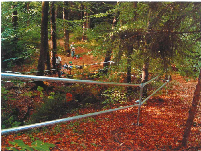
Arbeiten am Geländer der „Breitensteiner Bäuerin“; Foto: Dr. Walter Dietrich-Götz
