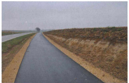
Abb. 11: Während der Geländebegehungen im März 2011 war an der Straßenböschung S-lich Forst der Bereich Arietensandstein (Lias alpha3)- Lias beta/gamma über längere Distanz angeschnitten. Die Kalksandsteine des Lias alpha3 gehen nach oben in quarzreiche Kalke und schließlich in fossilreiche, weitgehend quarzfreie Kalke und Mergel über. Dieses Paket bildet die Liasstufe über dem Feuerletten, ist aber wegen der wechselhaften Ausbildung des Feuerletten oft nur wenig akzentuiert.
