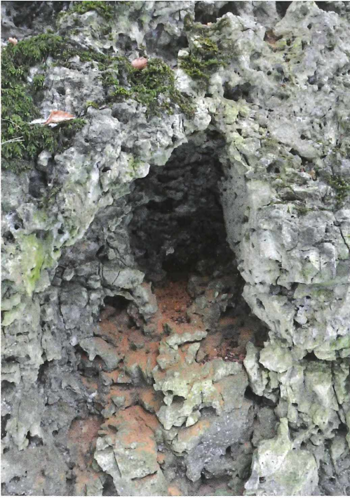
Abb. 29: Kavernöses bis pseudobrekziöses Gefüge mit Dolomitsand-Akkumulation. Spätstadium der Dolomitverwitterung mit Destabilisierung größerer Gesteinsbereiche. Diese Ansicht verdeutlicht, warum fortschreitende Lochverwitterung mit zunehmender Austrocknung und versiegenden Wasseraustritten verbunden ist: Die Zunahme an Makroporen und größeren Hohlräumen enthält keine horizontalen Sickerbarrieren mehr, die das Wasser zur Außenseite des Gesteins leiten könnten. – Wasserstein, entlang der Straße Höchstädt-Betzenstein, Oberes Kimmeridge (GK25 Betzenstein)
