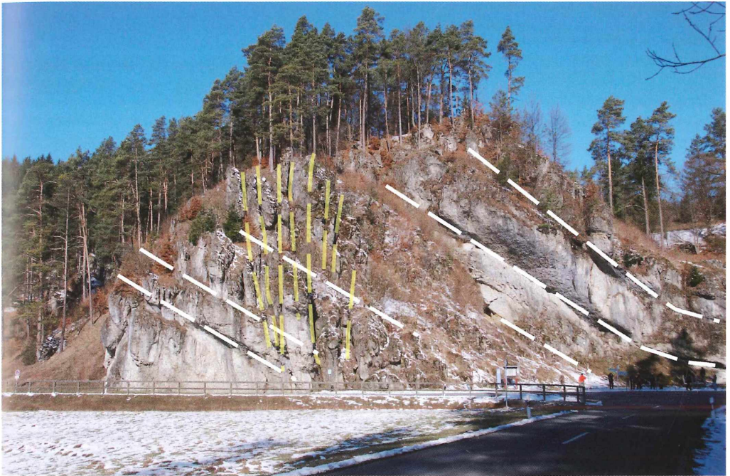
Abb. 10: Trennflächen im Dolomitfels. Weiß markiert: Schichtflächen. Die relativ steil nach rechts (Osten) geneigten Flächen sind Indiz für eine Position am Rand eines kuppelförmigen Massenfazies-Vorkommens („Riff“). An den Fugen hat bereits eine deutliche Unterhöhlung stattgefunden; an vielen Stellen tritt Sickerwasser aus. Abgesehen von der starken Schichtneigung zeigt dieser Fels die charakteristische Erscheinungsform der als tafelbankig bezeichneten Dolomit-Fazies. Gelb markiert: nahezu senkrechte Kluftflächen, die in einer Schar gebündelt den Fels durchschlagen. Solche Flächen fungieren prinzipiell als Anlage für die Zerteilung einer Felsgruppe in einzelne Türme. Wenn die Kluftabstände allerdings so eng angeordnet sind wie in diesem Fall, wird vermutlich die gesamte Kluftzone als Ganzes der rascheren Verwitterung zum Opfer fallen und letztlich einen 2-3 m breiten Kluftgang hinterlassen. – Mittleres Kimmeridge am westl. Ortsausgang von Obertrubach („Blechstein“) (GK25 Betzenstein)
