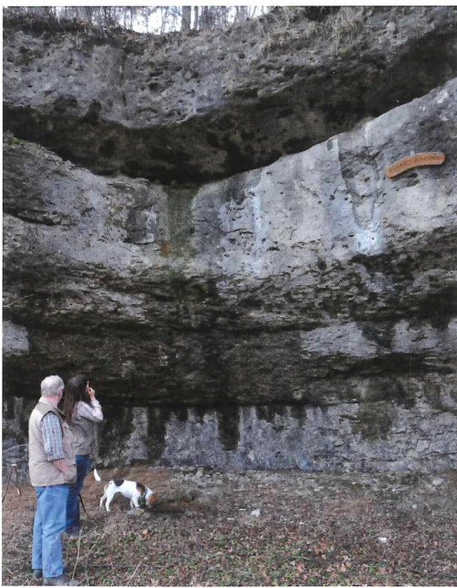
Abb. 11: Von den Schichtfugen des tafelbankigen Dolomits ziehen breite Sickerwasser-Bahnen herunter. An der obersten Schichtfuge ist es bereits zur Konzentration auf – vorerst noch – kleine, höhlenartige Sickerwasser- Austritte gekommen. Die Frontflächen sind hingegen durch eine dünne Kruste stabilisiert, deren Besiedlung durch Bakterien die graue Färbung verursacht. – Schindersbrunnen nördl. Schirradorf, Mittleres Kimmeridge (GK25 Weismain)
