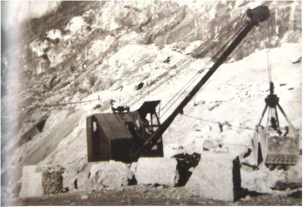
Abb. 7: Etwa um 1960 wurden mit Unterstützung des abgebildeten Kranes Wasserbausteine gewonnen.
