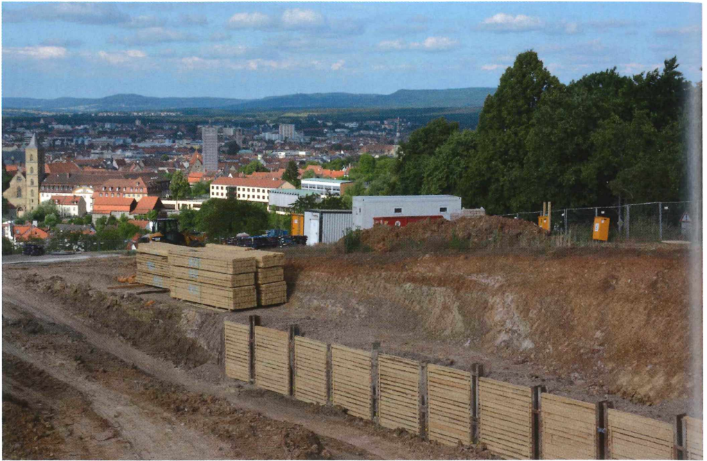
Abb. 3: Baugrube zum Hochbehälter West, Bamberg. Die obersten 1-3 m unter Geländeoberfläche sind von hangabwärtigen Kriech- und Fließbewegungen verstellt (Exkursion am 21. Juni 2014)
