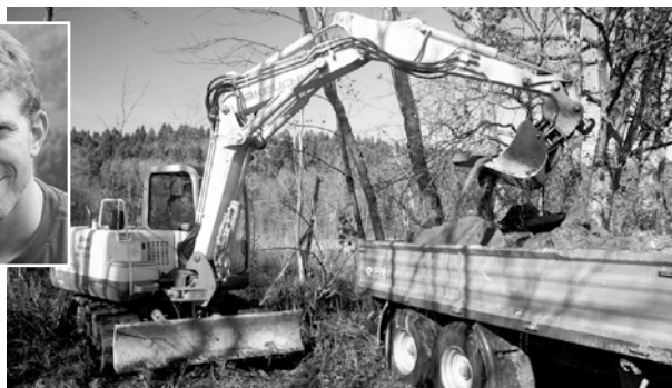
Alter Bauschutt wird aus dem Wallerbach entfernt.
