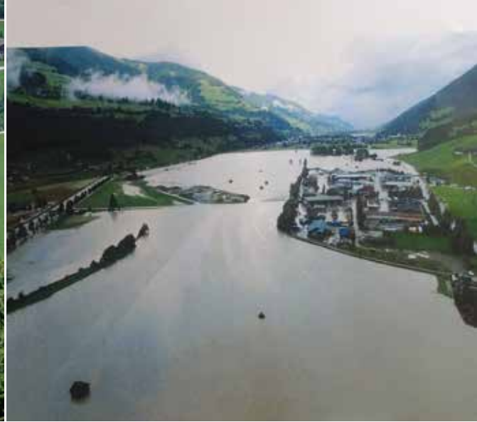
Geflutetes Hochwasser-Rückhaltebecken in Mittersill © HANSJÖRG NEUMEIER
