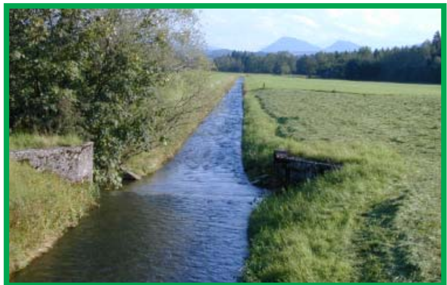
Der Eisbach wurde in den 30iger Jahren nach den damals herrschenden Grundsätzen reguliert – mit Regelböschungen, betonierten Sohlabstürzen und einem schnurgeraden Verlauf (Bild: Kumpfmüller).
