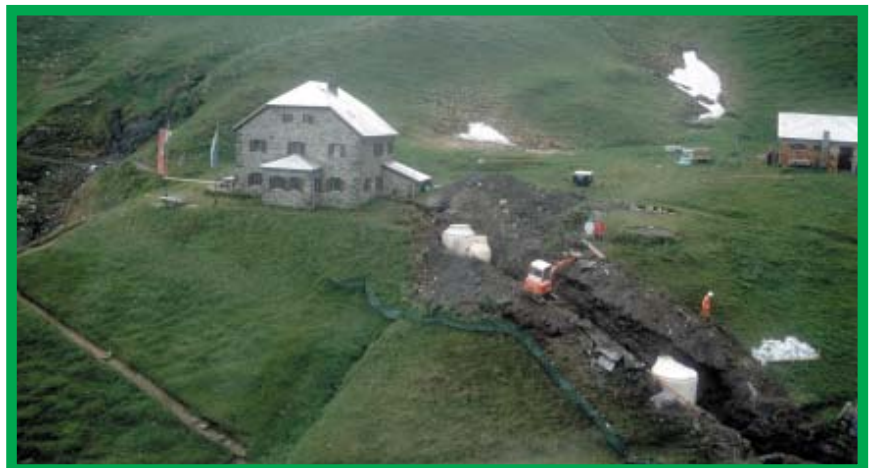
Errichtung einer Einzelkläranlage für die Gleiwitzer Hütte (Bild: W. Kunrath).
