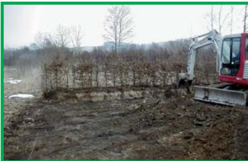
Abb. 2: Abtragung der bis zu 60 cm mächtigen Aufschüttungen.
