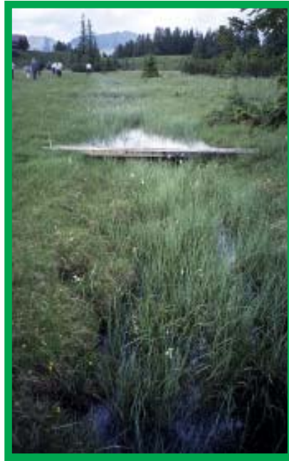
Abdichtung eines Entwässerungsgrabens.
