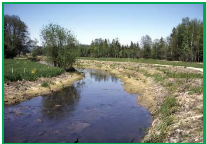
Im vergangenen Frühjahr wurde der kanalartige Eisbach auf einer Länge von 650 m wieder in ein naturnahes Gewässer umgewandelt.
