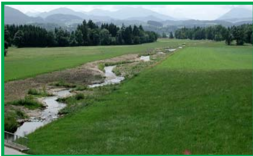
So präsentierte sich der restrukturierte Abschnitt des Eisbaches von der Westbahnstrecke aus unmittelbar nach der Fertigstellung im Mai 2002 (Bild: Kumpfmüller).
