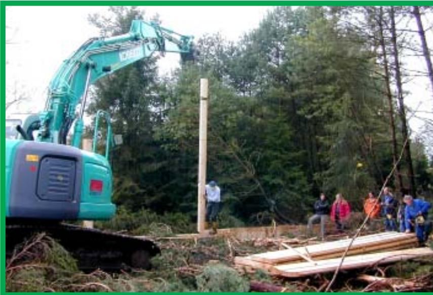
Bau der Holzquerwerke aus 8 cm starken und bis zu 6 m langen Tannebohlen (Bild: Kumpfmüller).
