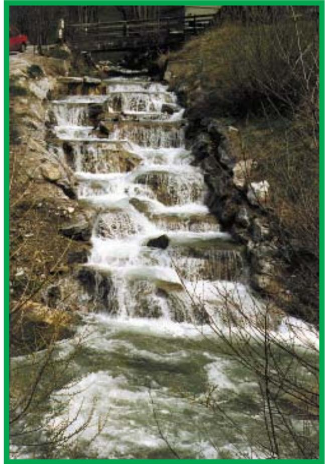
Durch Fischpässe werden zum Beispiel durch Kraftwerke unterbrochene Lebensräume (Bild links) wieder fischdurchgängig (Bild rechts) gemacht, wie hier am Beispiel eines Tümpelpasses beim Kraftwerk Rottenwänder, Zederhaus (Bilder: Gewässerschutz).
