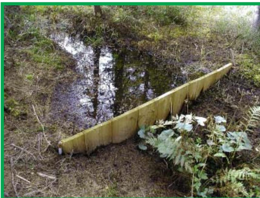
*Das Bauprinzip der Abdämmungen mit Nut und Feder (Bilder: G. Friese).*
