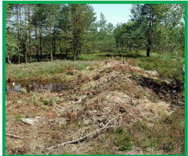
Fertiggestelltes Querwerk mit Überdeckung aus Torf und Hochmoorvegetation.
