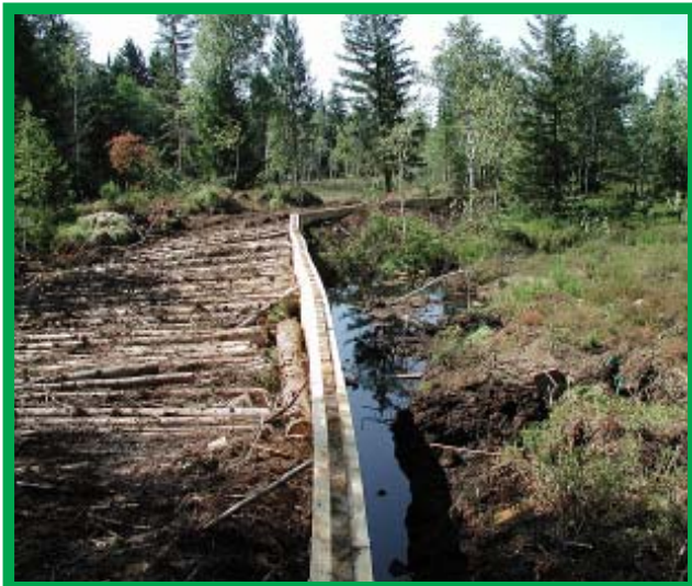
Längstes Querwerk mit 100 m, Arbeitsplattform aus geschlägerten Fichtenstämmen mit Stützfunktion.
