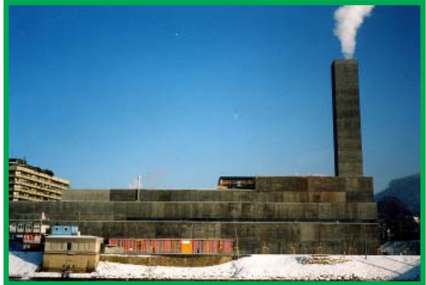
Heizkraftwerk Salzburg-Mitte: optisch missratener Koloss im Stadtgebiet (Bild: H. Hinterstoisser).
