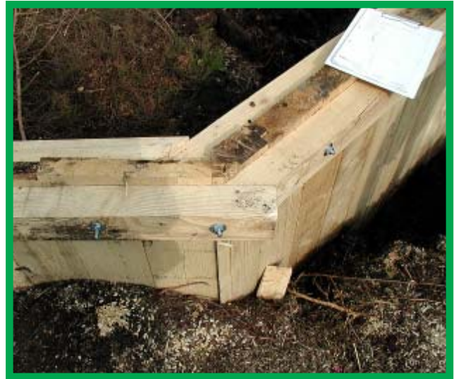
Tannenzspundwand im Detail: 50 bis 80 mm starke Nut-Feder-Bohlen mit verschraubten Zangenhölzern.
