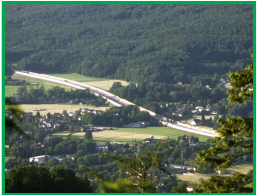
Lärmschutzwände an der Autobahn (Bild: W. Schütz).
