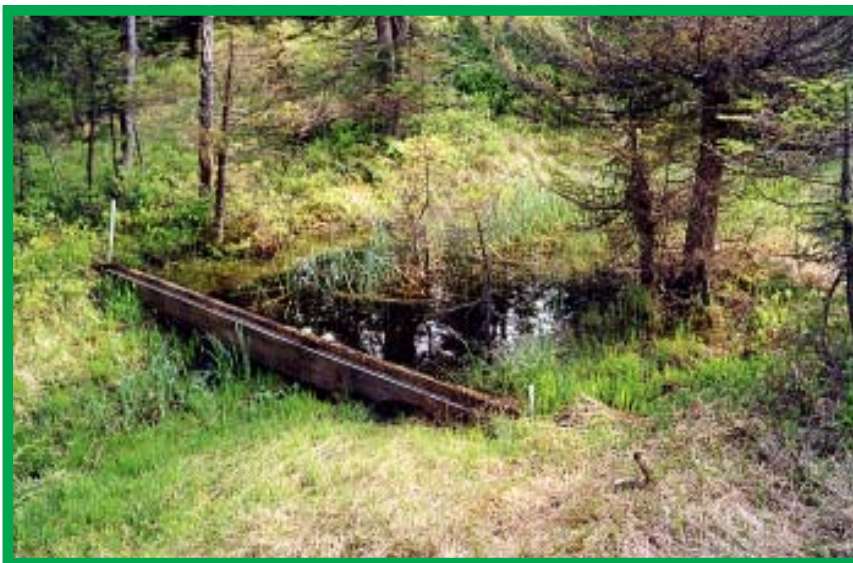
Lärchen-Spundwand zur Wasserretention fördert die Wiedervernässung ehemals drainagierter Moorflächen.
