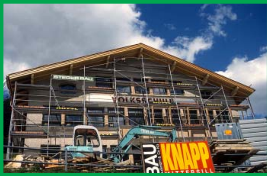
Umbauarbeiten an der Volksschule in Wald (Bild: M. Jerabek).
