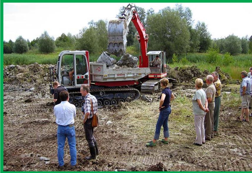
Spatenstich am 22.7.2004; als Baumaterial für die Dämme wird der anstehende Glazialton verwendet (Bild: Revital ecoconsult).
