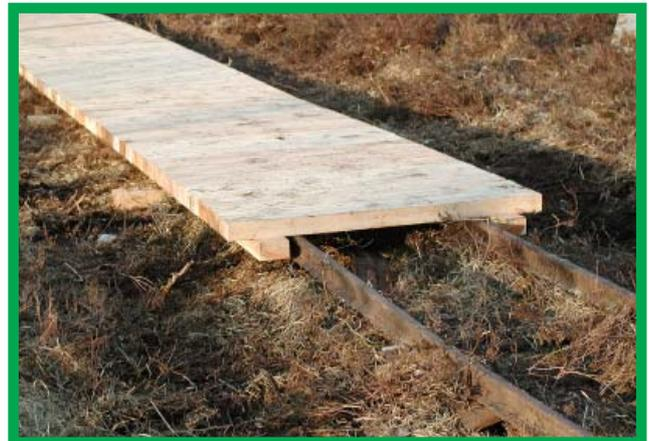
Der neue Weg folgt weitgehend dem Verlauf der alten Torfbahn. Die noch vorhandenen Gleise werden als Längslager genutzt (Bild: B. Riehl).
