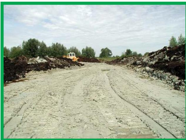
Damm 1 während der Bauphase – gut sichtbar ist die breite Dammbasis (Bild: B. Riehl).
