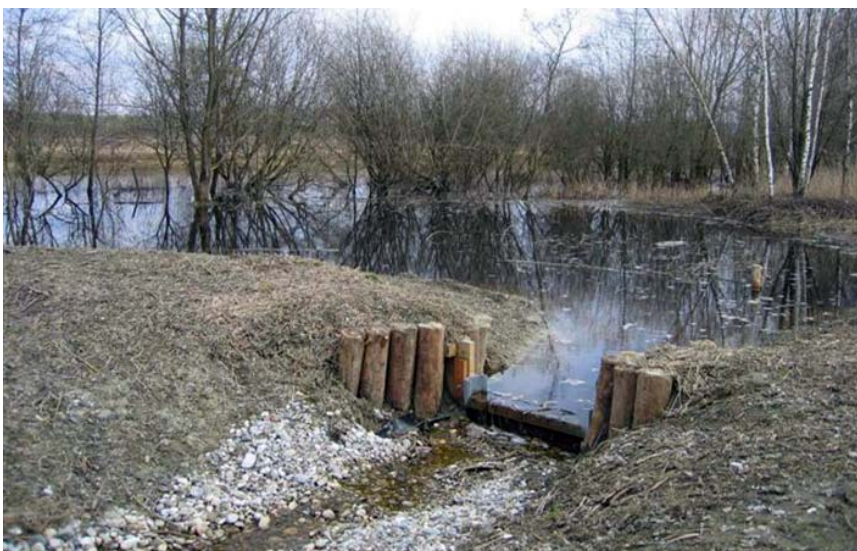
Dieser Überlauf wird bereits überströmt (© Ragger).
