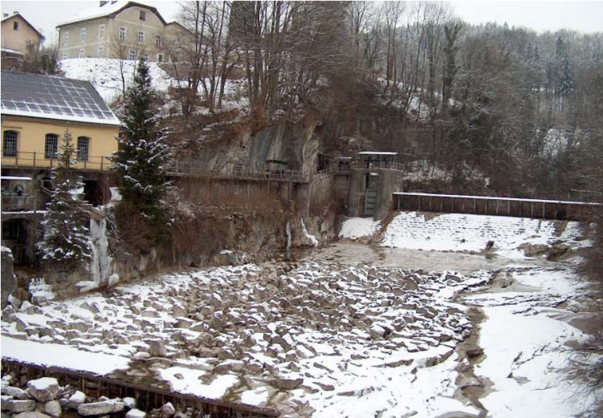
Der trostlose Zustand des Almbachs ohne Restwasser unterhalb der „Hammerwehr“ (Bild: M. Neureiter).
