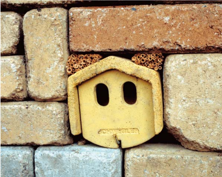
Der Naturschutzbund baut eigens gefertigte Nischenbrütherhöhlen in gut integrierbare Strukturen wie Stützmauern oder Kräuterspiralen ein (Bild: Gepp).
