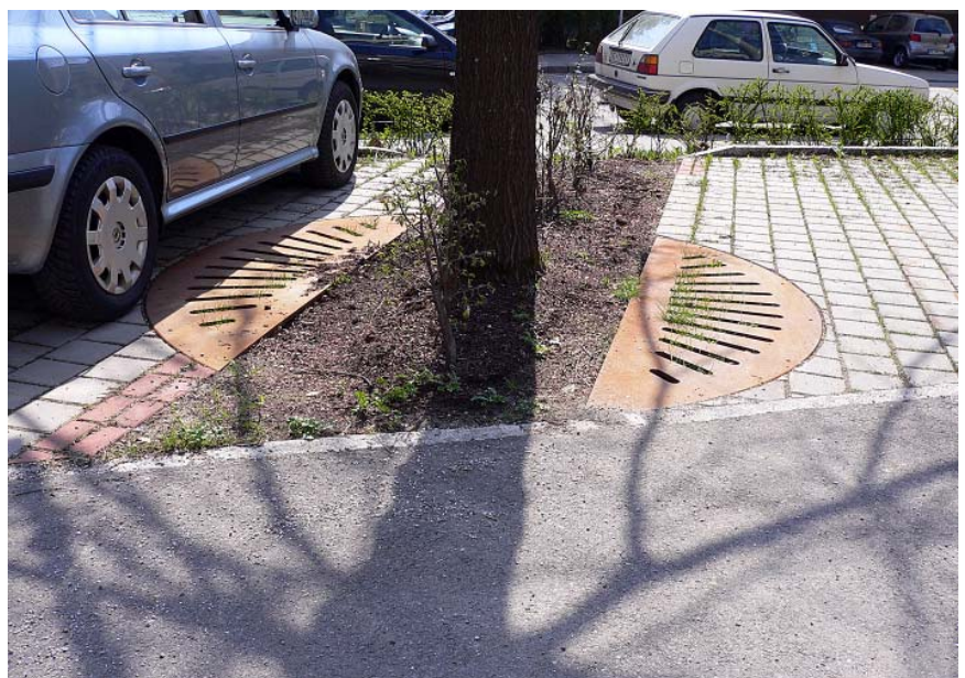
Gelochte Betonscheiben sollen für Bodenbelüftung rings um einen Baum auf einem städtischen Parkplatz sorgen (Bild: G. Frieße).
