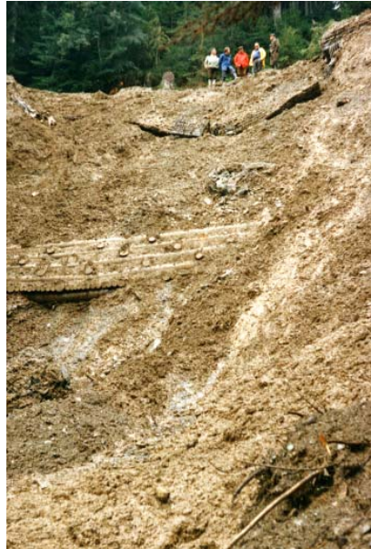
Zell am See: Murenabbruch Pfaffenbach, Schiabfahrt mit überschütteter Krainerwand (Bild: H. Hinterstoisser).
