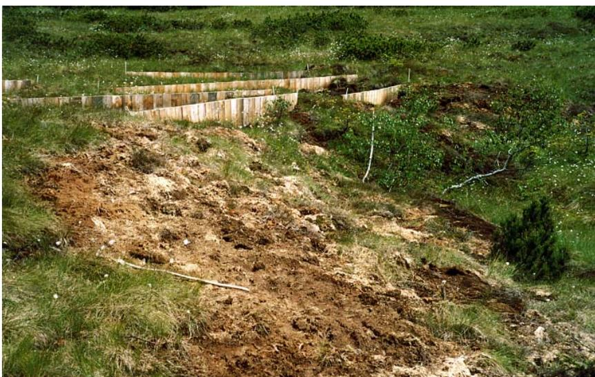
Beispielgebende Moornaturierung durch die ÖBf-AG im Ramsar-Schutzgebiet „Wasenmoos am Pass Thurn“ bei Mittersill: frisch gesetzte Lärchen-Spundwände führen zum Rückstau in alten Drainagegräben (Bild: H. Hinterstoisser).
