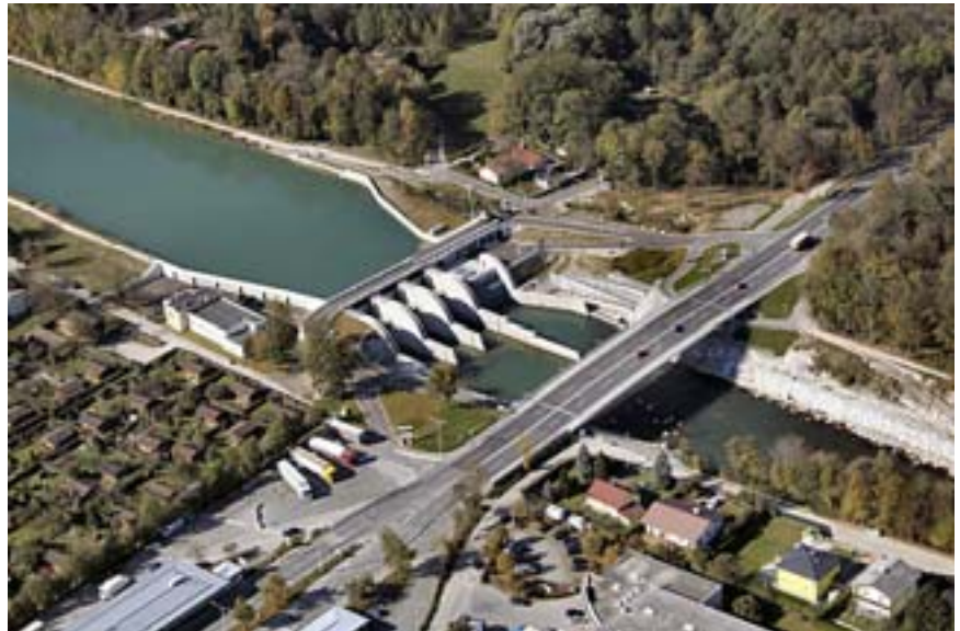
Saalach-Fischpass bei KW Rott (Bilder: Salzburg AG).
