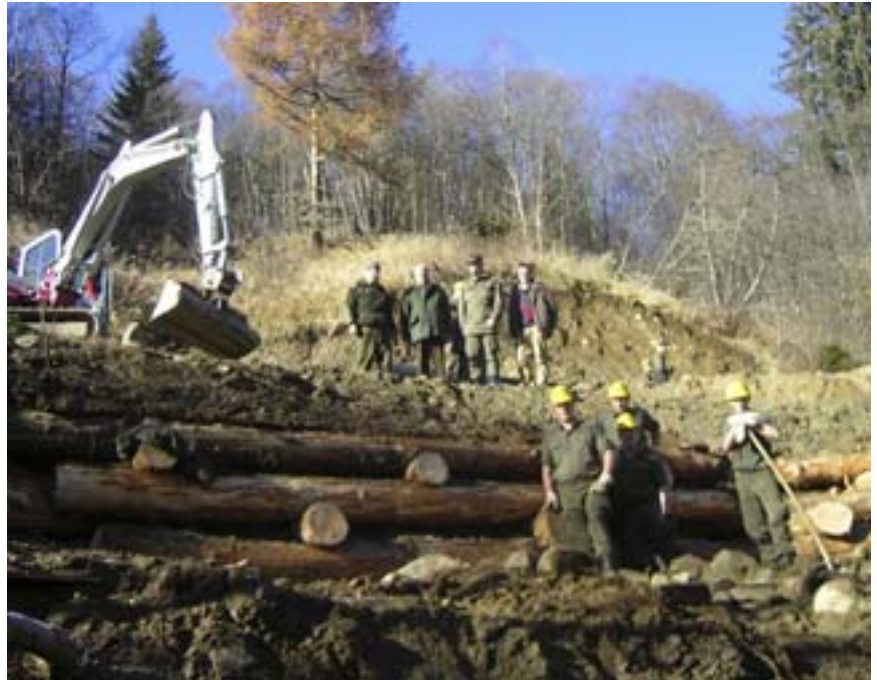
Hangsicherung in unzugänglichem Gebiet durch das Bundesheer (Bild: LK).
