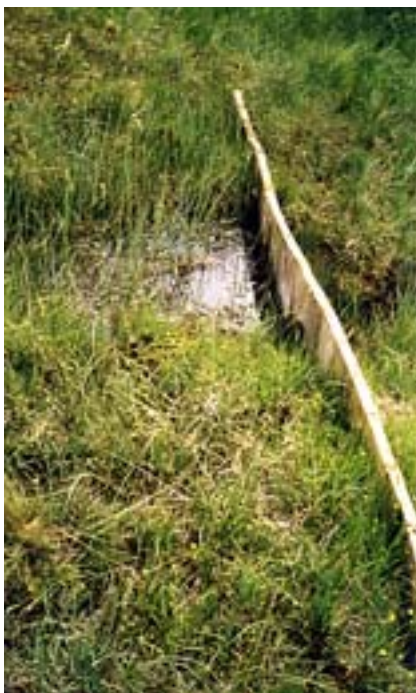
Ramsar-Schutzgebiet „Wasenmoos“ am Pass Thurn bei Mittersill: beispielgebendes Projekt der ÖBF-AG zur Renaturierung. Lärchenspundwand in Nut- und Federkonstruktion staut einen alten Entwässerungsgraben zur Regulierung des Moorwasserhaushalts auf (Bilder: H. Hinterstoisser).
