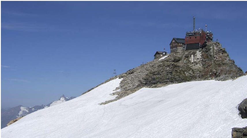
Im Bereich des Rauriser Sonnblicks (mit Observatorium und Zittelhaus) waren umfangreiche Felssicherungsmaßnahmen notwendig, um die Standfestigkeit des Gipfels sicherzustellen (Bild: W. Schöner).
