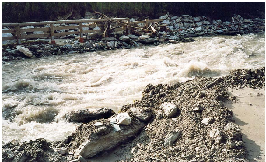
Flüsse brauchen Raum zum Ausufern. Durch Hochwasser im Sommer 2006 zerstörte Uferverbauung (Bild: H. Hinterstoisser).
