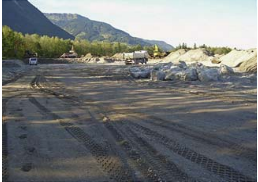
Hochwasserschutz Golling. Arbeiten zum zweiten Bauabschnitt haben begonnen (Bild: LPB/Riegler).
