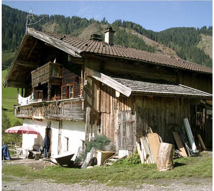
Das Vorderwaldgut in Fusch der Familie Schattbacher in seinen ursprünglichen Zustand (Bild: LK).
