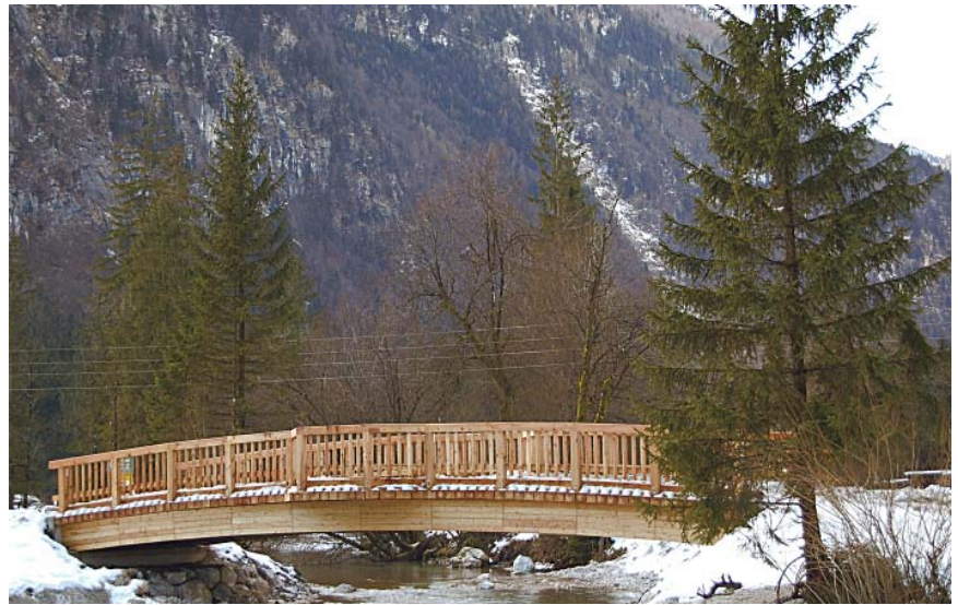
Neue Holzbrücke im Bluntautal in Golling (Bild: LPB/Riegler).
