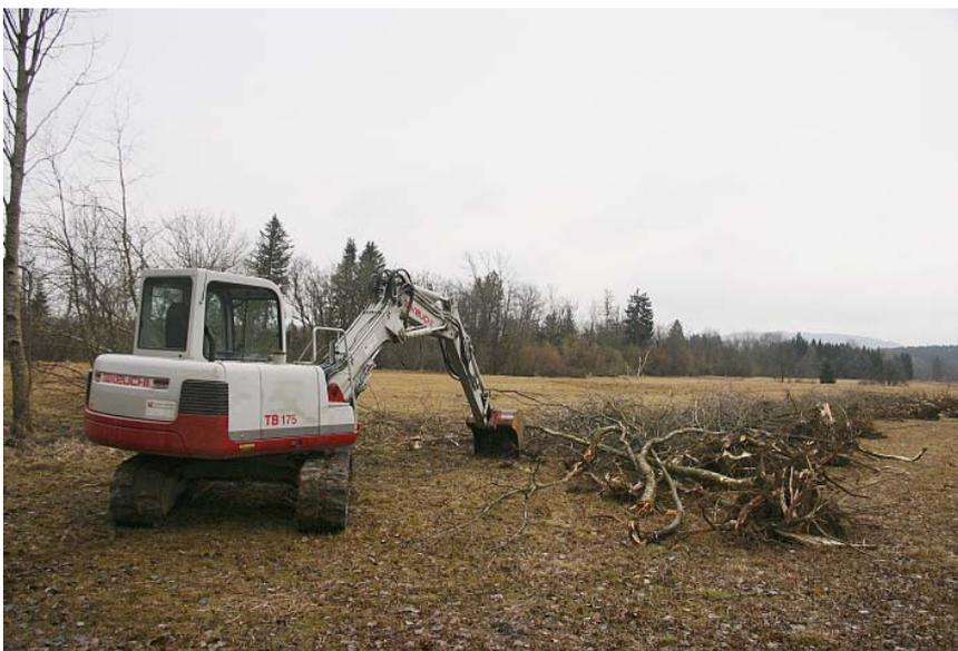
Abb. 4: Maßnahmenumsetzung im ESG/NSG Wenger Moor: Im Bereich eines tieferen Grabens wurde ein Bagger eingesetzt, der die Bäume mitsamt den Wurzelballen entfernte und danach die Grabenböschung wieder aufplanierte (Bild: O. Stöhr).
