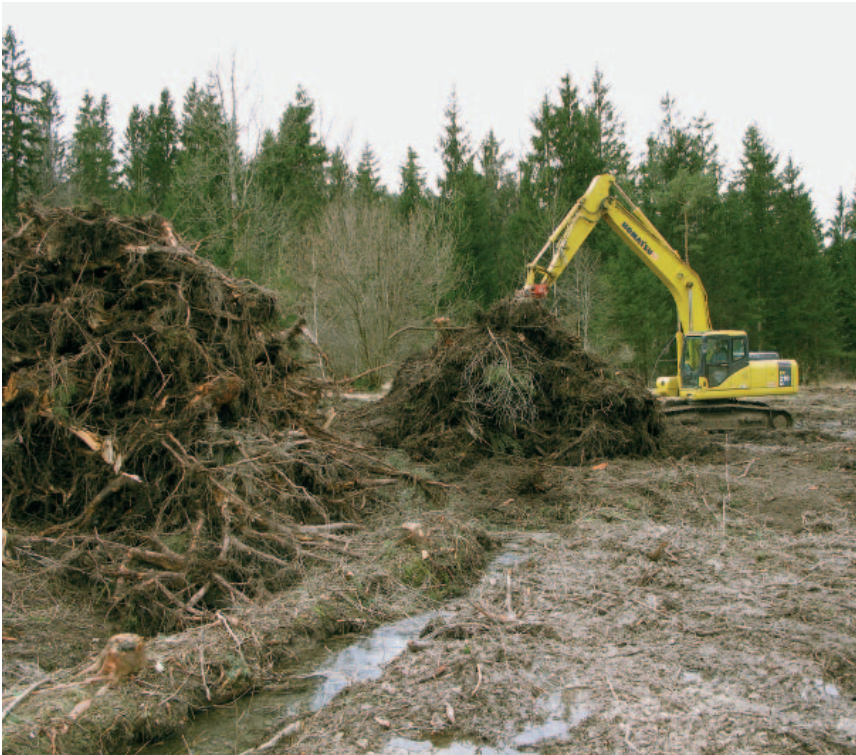
Die Wurzelstöcke werden von einem Bagger aus der Erde gerissen, abgeschüttelt und am Manipulationsplatz zwischengelagert (15.03.2008; Bild: A. Waldmann).
