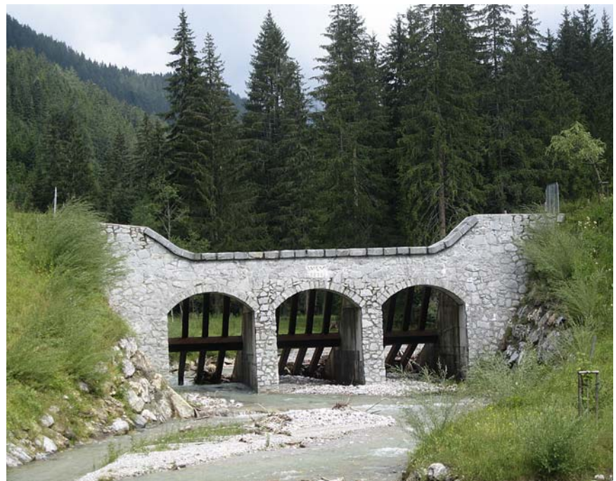
2004 gebaut und bereits gut in die Landschaft eingefügt: Sortierwerk an der Warmen Mandling mit durchgehendem Sohlkontinuum.
