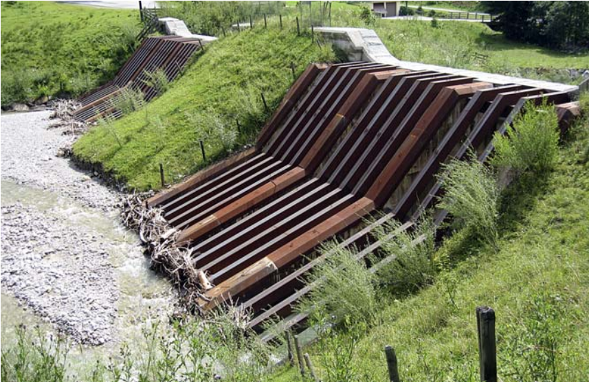
Sortierwerk mit abgeschrägtem Rechen.
