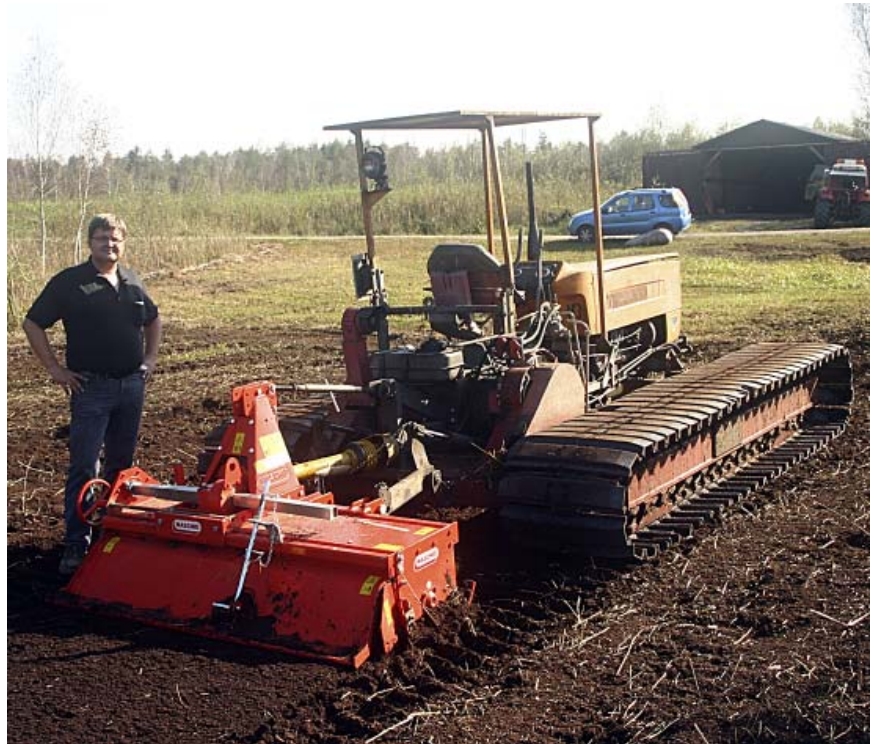
Einsatz der neuen Bodenfräse im NSG/ESG Weidmoos (Bild: O. Stöhr).
