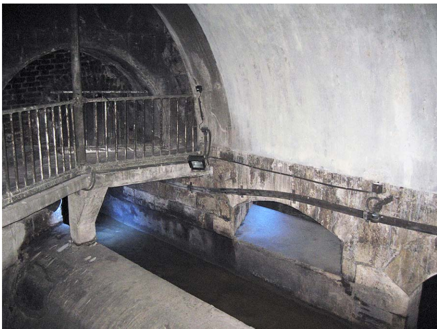
Zusammenfluss des Ottakringer Baches im Wiener Kanalnetz: einer der Drehorte für „Der Dritte Mann“ (alle Bilder: H. Hinterstoisser).
