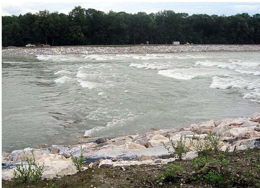
*Aufgelöste Rampe an der Salzach bei Oberndorf kurz nach der Fertigstellung. Mit der Errichtung der zweiten ursprünglich geplanten solchen Rampe wäre die Salzach zu sanieren (Bild: H. Hinterstoisser).*
