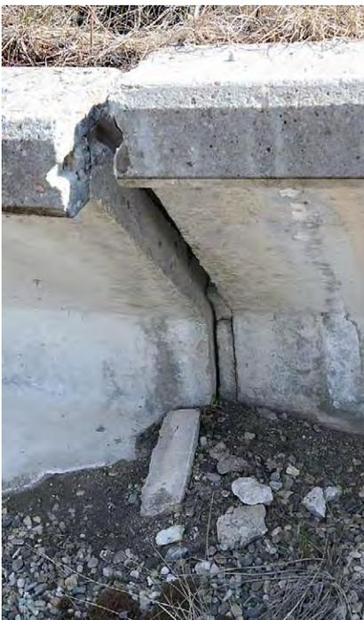
Abb. 1: Die 1994 errichtete Amphibienschutzanlage an der B 99 Katschbergstraße in der Twenger Au zeigte nach 15 bis 20 Jahren deutliche Schäden.
