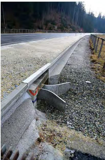
Die Amphibienschutzanlage „Twenger Au“ an der B 99 Katschbergstraße wurde nach 25 Jahren vom Straßenbau aufwendig saniert.
