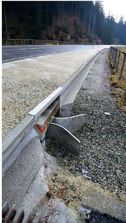
Abb. 2: Nach Abschluss der Arbeiten ist die Leiteinrichtung talseitig wieder geschlossen und die Entwässerung teilweise erneuert.
