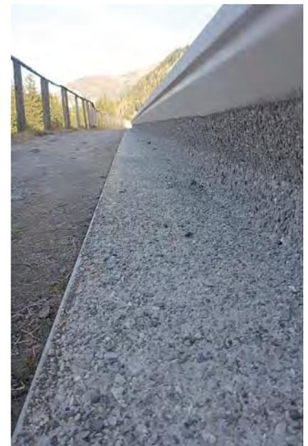
Abb. 3: Die Durchlässe wurden zum Teil verkürzt, um zwischen der Schutzanlage und dem Nachbargrund leichter Mähen zu können. Die Bauteile entsprechen mit der Waschbetonoberfläche dem Stand der Technik.
