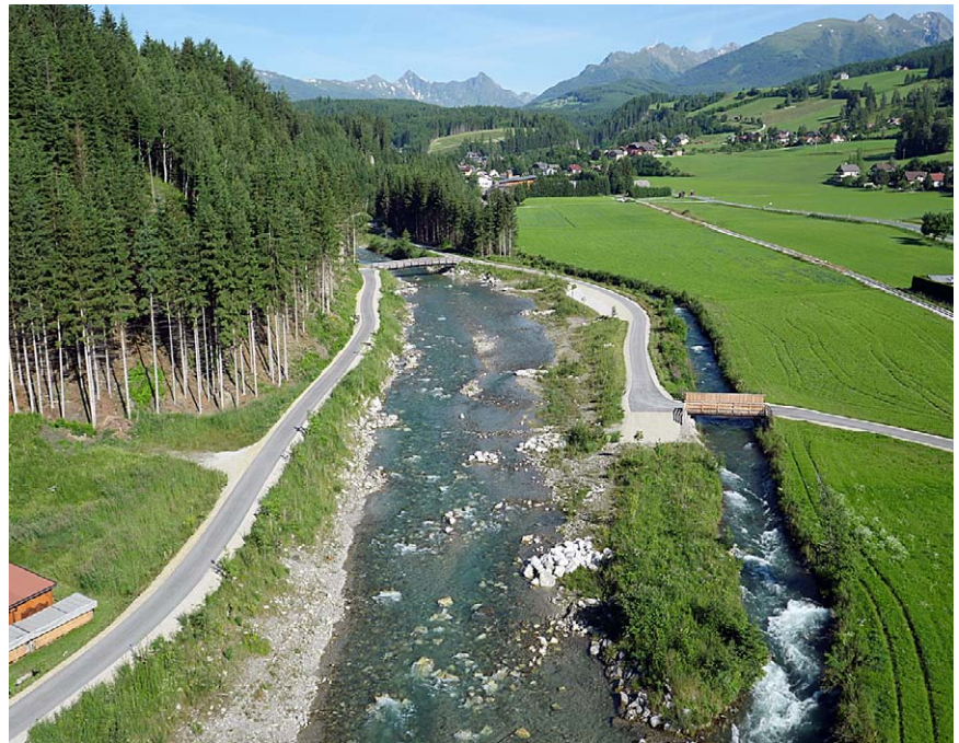
Hochwasserschutz Taurach (Bild: Land Salzburg).
