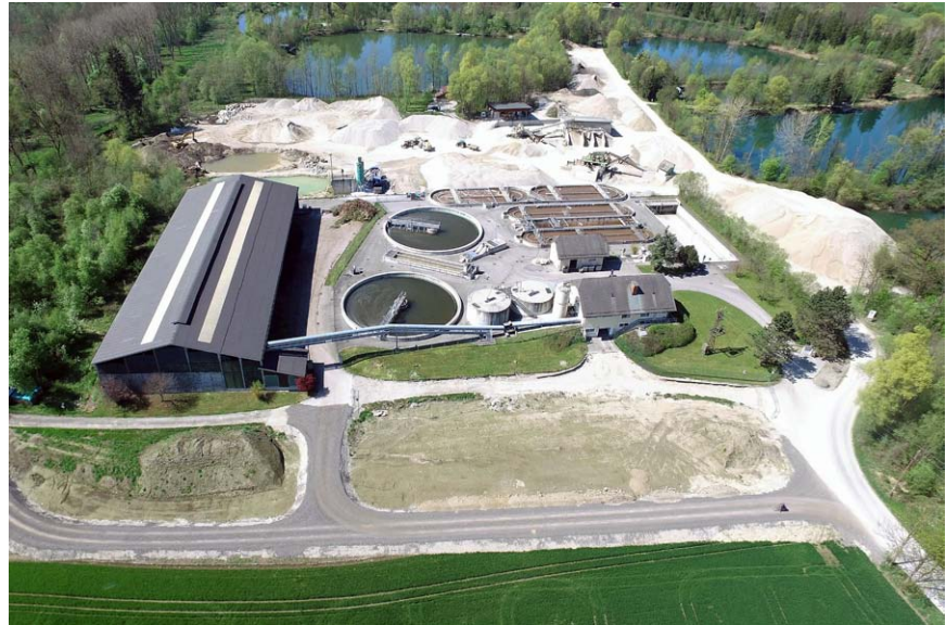
Kläranlage Pladenbach (Bild: Gewässerschutz).
