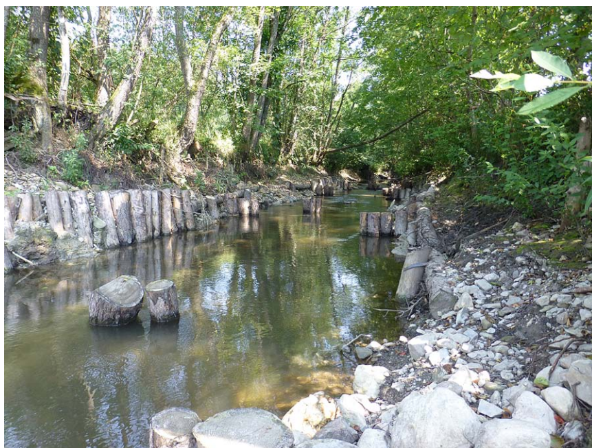
Flussrenaturierung Oichten (Bilder: Land Salzburg).
