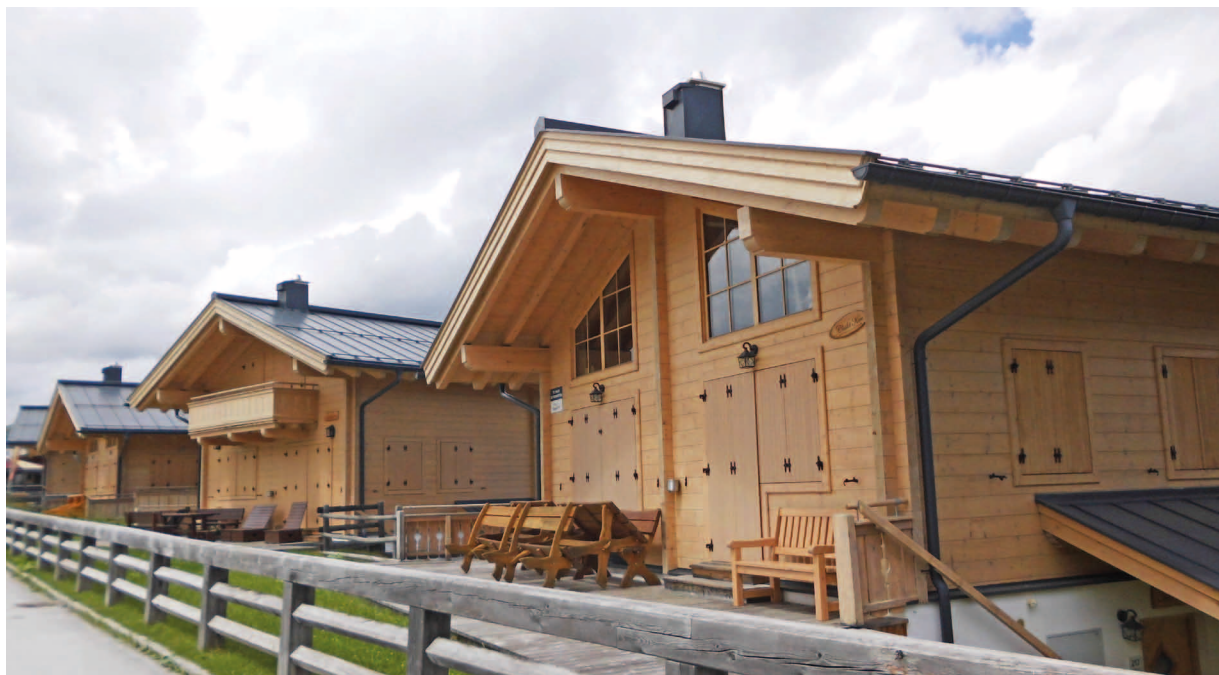
Geisterstädte in den Alpen: Zweitwohngebiet im Pinzgau - trotz Bauplatzmangels (Bild: H.Hinterstoisser).
