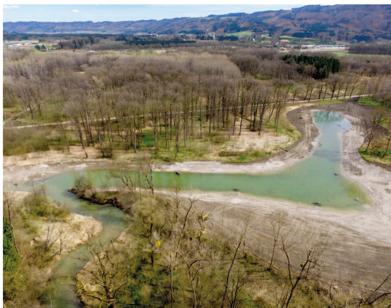
Die 4 ha große Vorlandabsenkung Nr. 4 mit dem neuen Reitbach-Seitenarm; den Bachlauf sieht man links unten im Bild (Bild: REVITAL).
