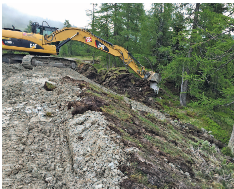
Aufbringen von Vegetationsteilen auf einer neu entstandenen Straßenböschung auf ca. 1.900 m in Flachauwinkl (Bilder: NMS GmbH, St. Veit im Pongau).
