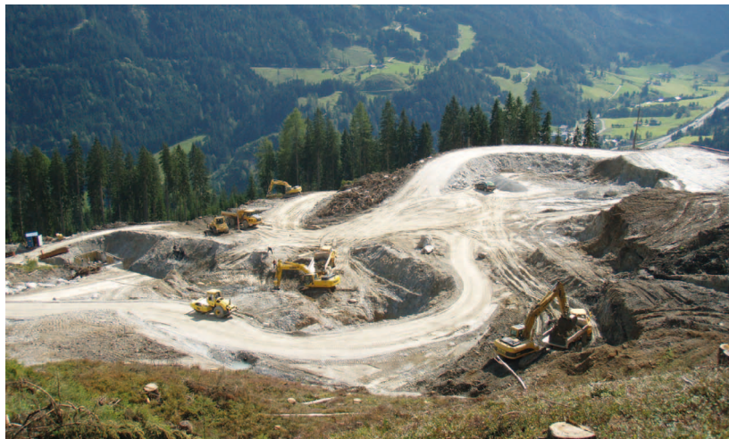
Baustelle des Speicherteichs Winkelalm (Bild: DI Karl Jordan).
