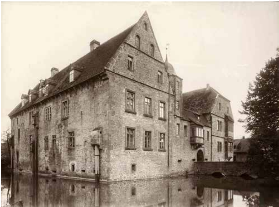
369 d Hülsede, historische Aufnahme des Wasserschlosses
