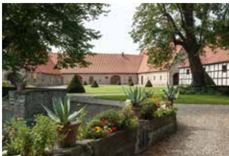
369 a Hülsede, Hofgebäude des Wasserschlosses
