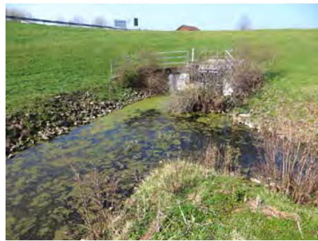
Abb. 3: Probestrecke 5. Zulaufgraben zum Salzgraben bei Sülbeck mit Deichunterführung im Hintergrund.
