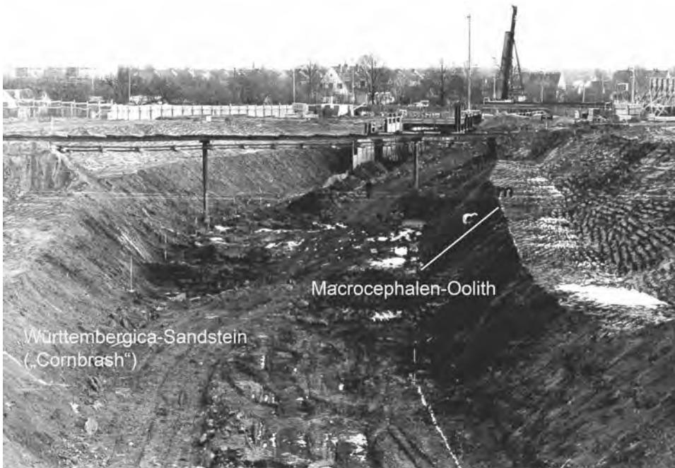
**Abb. 9** U-Bahn-Baugrube am Mühlenberg 1975 in Bathonium-Callovium Schichtenfolge; im Hintergrund Hamelner Chaussee/Wallensteinstraße. Rechte Bildhälfte: fossilreicher Macrocephalen-
