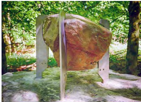
Abb. 6 Der Schweden-Findling ist ein Naturdenkmal. Er durfte daher für die Montage auf dem Sandstein-Sockel nicht angebohrt werden. Stattdessen halten vier Edelstahl-Klammern den Stein in Position und ermöglichen zugleich, ihn von allen Seiten zu betrachten. – Foto: F.-J. Harms.
