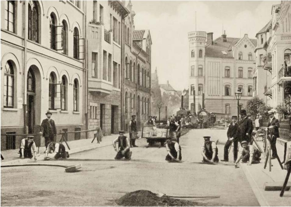
**Abb. 26** Herstellung von Hartgussasphalt auf Betonunterlage in der Straße Am Emmerberge in Hannover 1909. Aus DASAG (1926).
