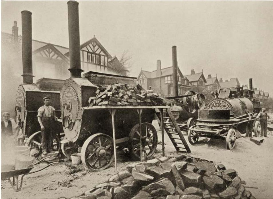
**Abb. 28** Herstellung von Hartgussasphaltbelag in der Fredrick-Street in Oldham bei Manchester 1913, 4,7 % Steigung. Aus DASAG (1926).
