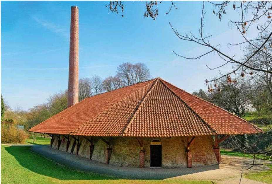
Rauchgase durch den Fuchs zum Schornstein, der durch seine Höhe den erforderlichen Zug gewährleistet.
