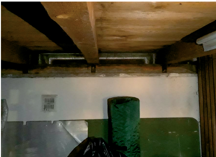
Bild 4: Blick vom Dachboden auf zwei nicht besetzte Brutnischen. (2021)
