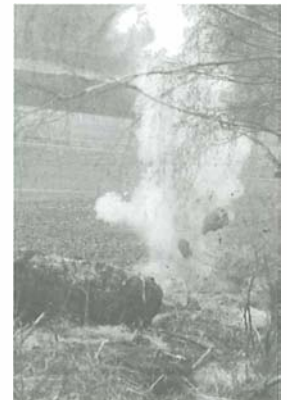
Bei der Sprengung ...
