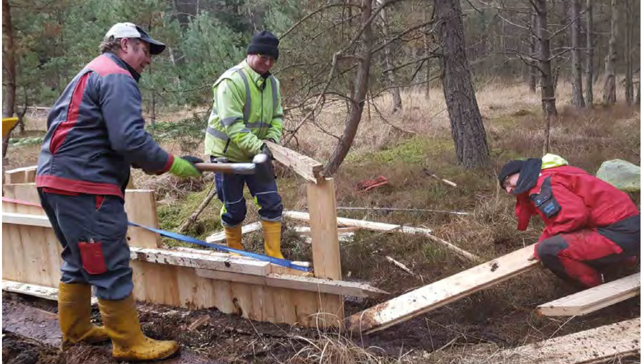
Einbau einer Holz-Spundwand im Dezember 2020 im Bummermoos
