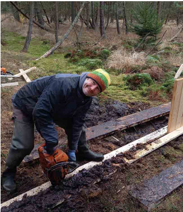
Beim Einbau der Holzspundwände im Bummermoos
