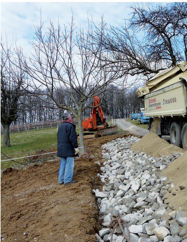
Abb. 4 bis 7 (von oben links): Nachdem die oberste Bodenschicht entfernt worden war, wurden an mehreren Stellen ca. 1 m 3 tiefe Löcher gegraben und mit Wurzelstöcken aufgefüllt. Dann wurden auf der Fläche frostsichere Steine verteilt und auf die Schottererschicht eine Schicht Sand aufgetragen. Den Abschluss des Steinriegels bildeten regionaltypische Blocksteine. Fotos: Ch. GOTTSCHLING.
