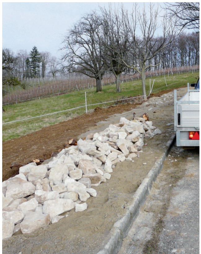
Abb. 4 bis 7 (von oben links): Nachdem die oberste Bodenschicht entfernt worden war, wurden an mehreren Stellen ca. 1 m 3 tiefe Löcher gegraben und mit Wurzelstöcken aufgefüllt. Dann wurden auf der Fläche frostsichere Steine verteilt und auf die Schottererschicht eine Schicht Sand aufgetragen. Den Abschluss des Steinriegels bildeten regionaltypische Blocksteine. Fotos: Ch. GOTTSCHLING.
