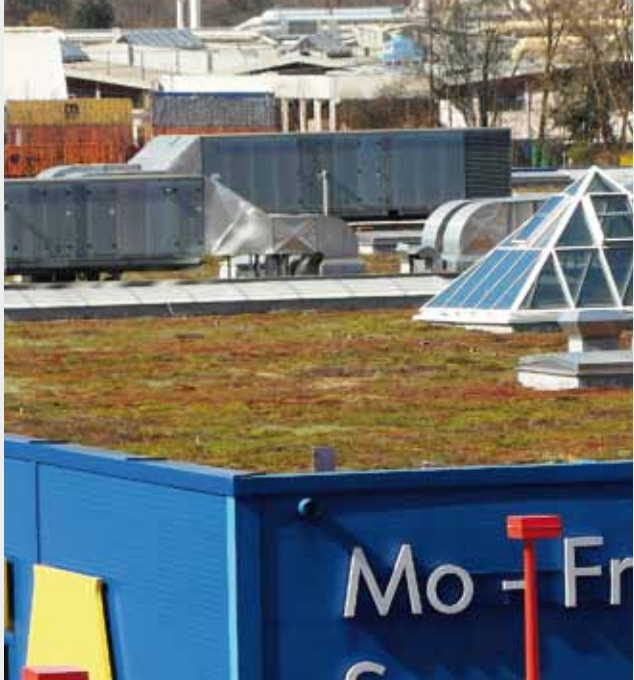
Betriebsgebäude mit extensiver Dachbegrünung
