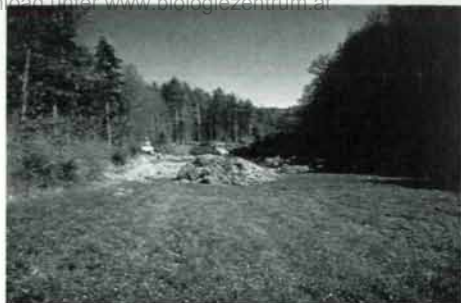
Bau einer dichten Lehmwanne
