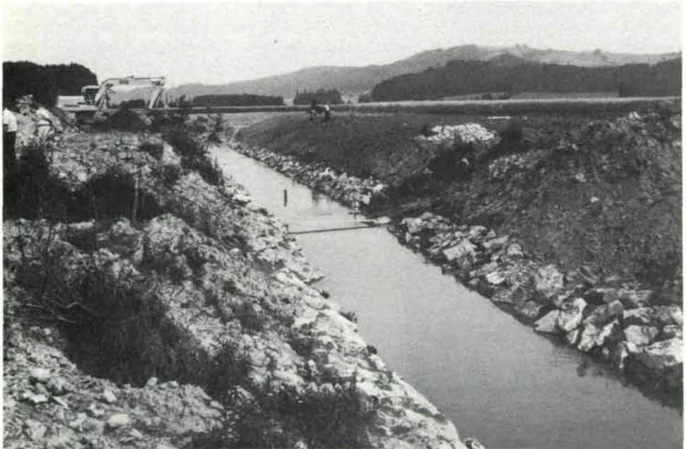
Ritschein kanal ohne Uferbewuchs
