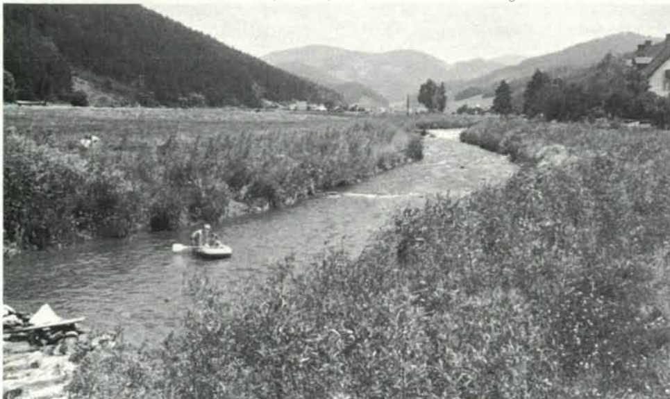
Der Gleinbach im Jahre 1982 – ca. 4 Jahre nach Fertigstellung der Bauarbeiten
