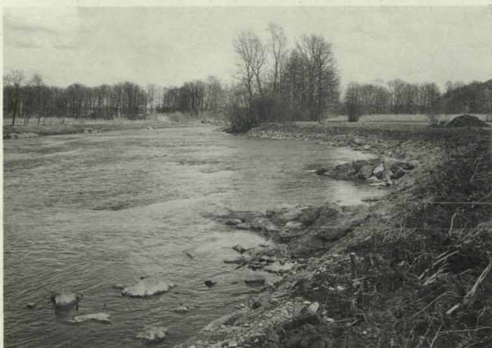
Naturgemäße Sanierung eines Uferanbruches durch Buhnen und Spreitlagen (Mündungsstrecke der Sulm).
