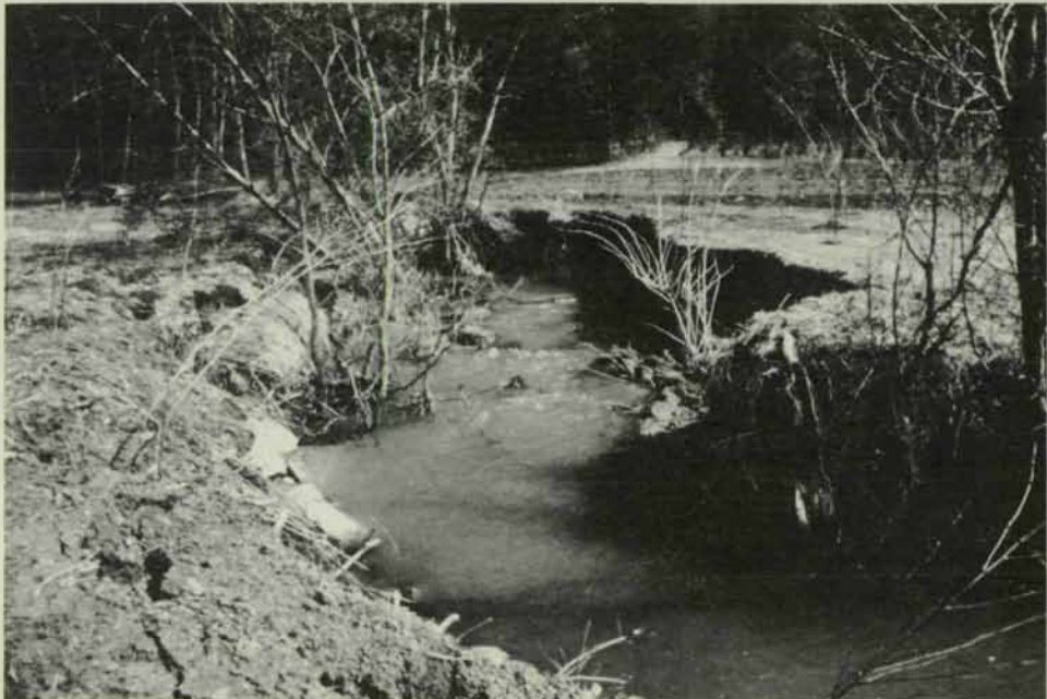
Lungitzbach, Rohr – St. Johann/H., Kleinmaßnahme 1983.
